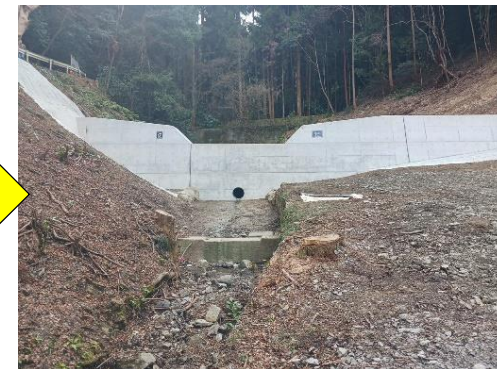
谷止工（R6完成）
