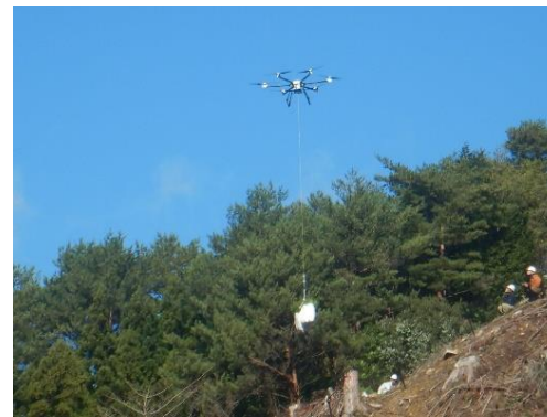
コンテナ苗をドローンで効率的に運搬
