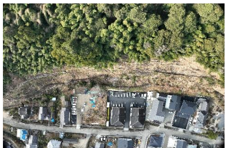
ドローンによる治山事業地調査
