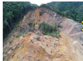
山腹被害状況（古屋国有林）
