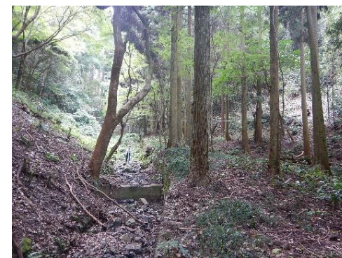
溪流荒廃状況（城山国有林）
