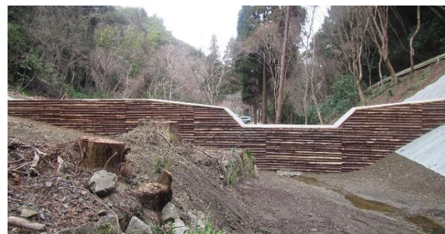
谷止工（残存型枠）
