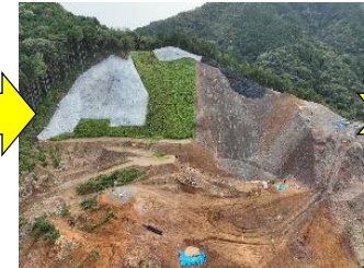
山腹工（R4 実行箇所）
