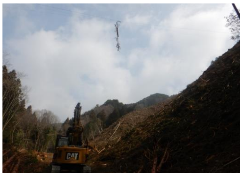
架線集材作業
