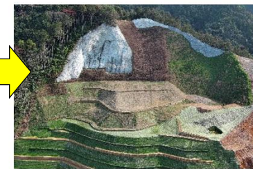
山腹工（R5 実行箇所）
