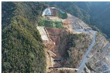
ドローンによる治山事業地調査
