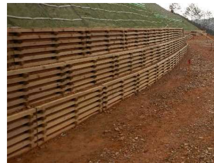
木製柵筋工（詰土）
