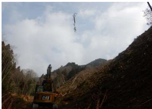
架線集材作業
