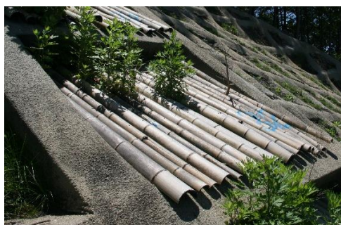
竹被覆工によるシカ侵入防止対策
