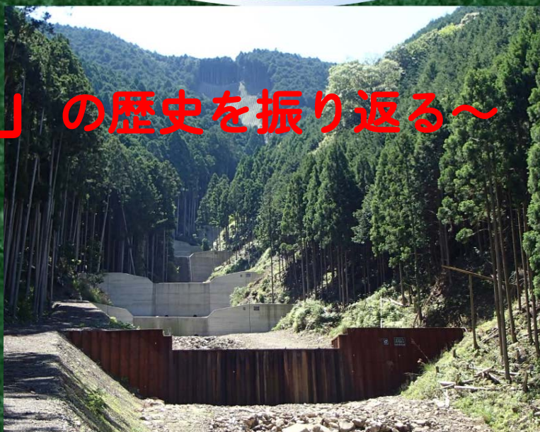
【山腹工施工箇所（和歌山県愛賀合地区）】
