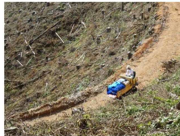
【フォワーダを利用した防護柵の運搬】
