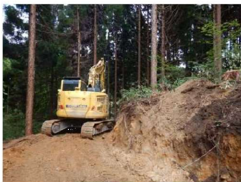
【森林作業道の作設】
