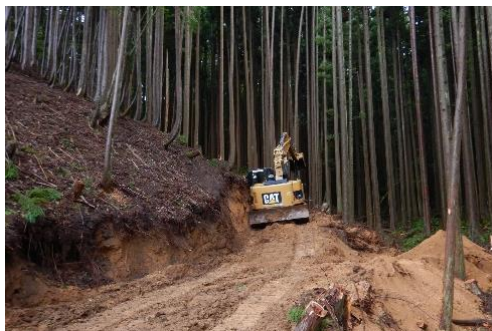
【森林作業道の作設】
