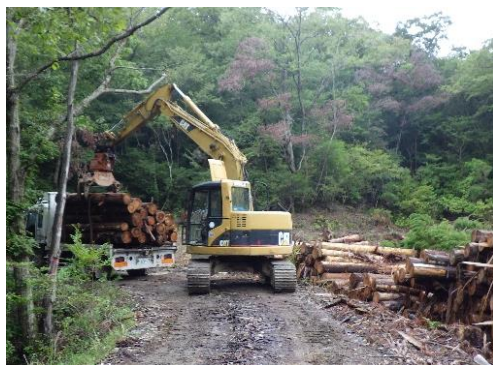
【トラックによる材の運搬】
