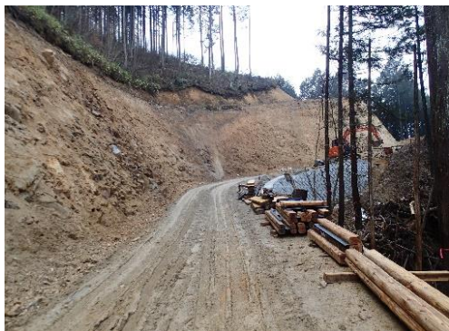
【林業専用道の新設】
