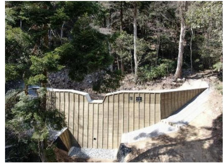
【木製残存型桝を使用した治山えん堤】
