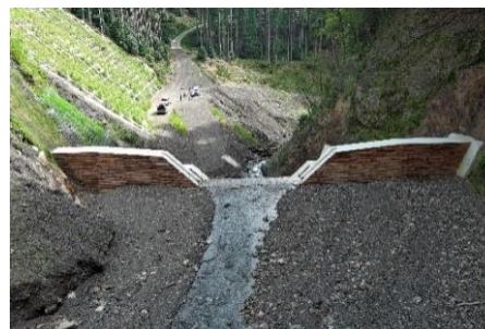
【間伐材を使用した丸太残存型枠 R7.9】 いまにし (吉野郡十津川村 今西工区)
