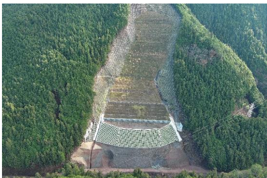
【山腹工施工状況 R7.12】 つほのうち (吉野郡天川村 坪内工区)
