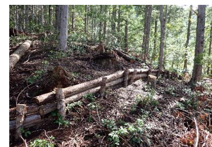
【間伐材を使用した丸太筋工 R7.10】 ほべだに (吉野郡上北山村馬部谷国有林) 奈良森林管理事務所
