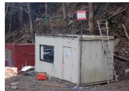
Starlink地上アンテナと Wi-Fiパッケージの設置状況
