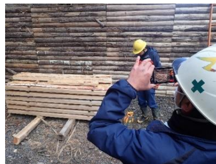
遠隔臨場による材料検査の実施状況
