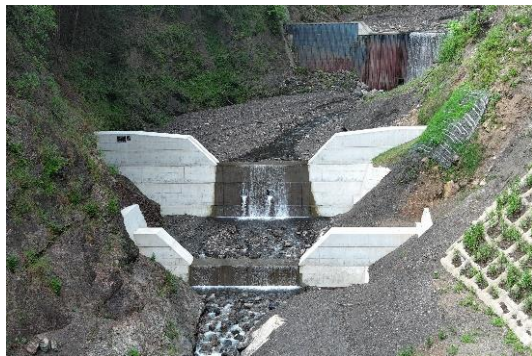
【溪間工施工状況 R7.9】 いまにし (吉野郡十津川村 今西工区)
