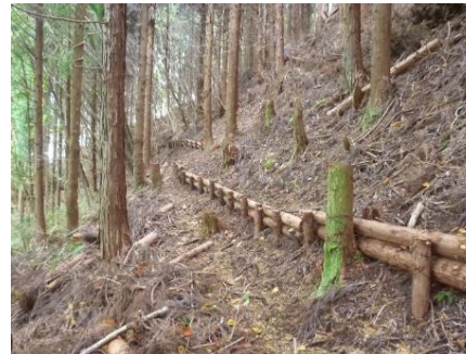
【間伐材を使用した丸太筋工】
