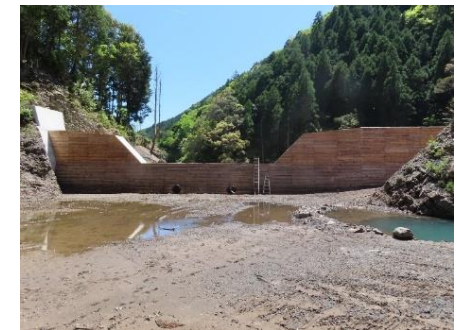
【間伐材を使用した 丸太残存型枠】
