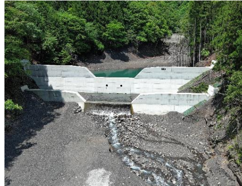
【溪間工施工状況】
