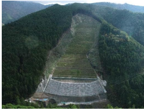
【山腹工施工状況】
