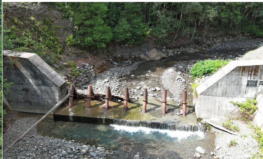
流木や土砂の流下を防ぐスリット谷止（令和7年9月）
