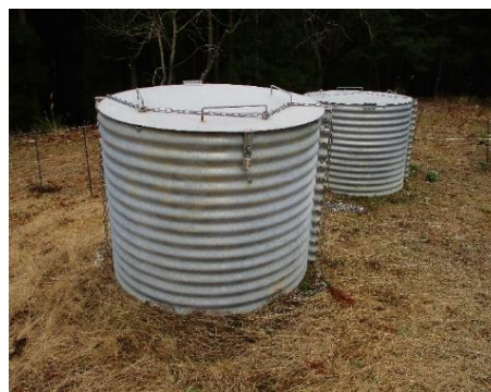
令和6年度に設置した 大型排水管
