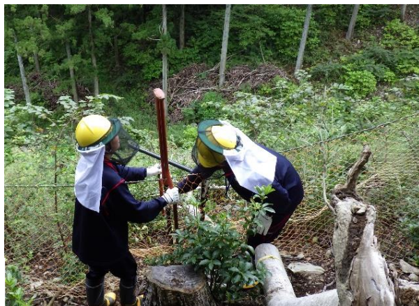
防護柵の修理作業▶
