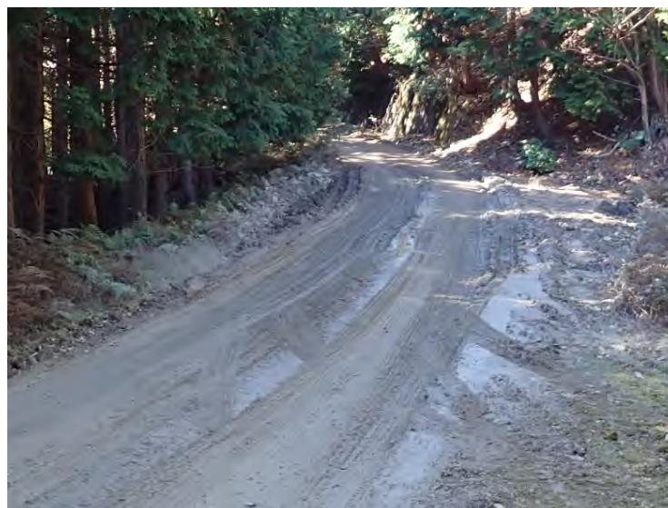
林道改良工事予定箇所 （悟入谷国有林 いなべ市）
