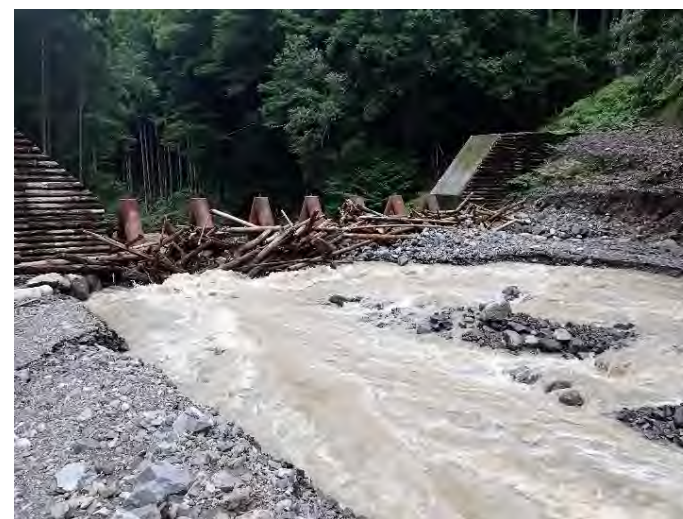
流木、土砂の捕捉状況(令和5年8月)
