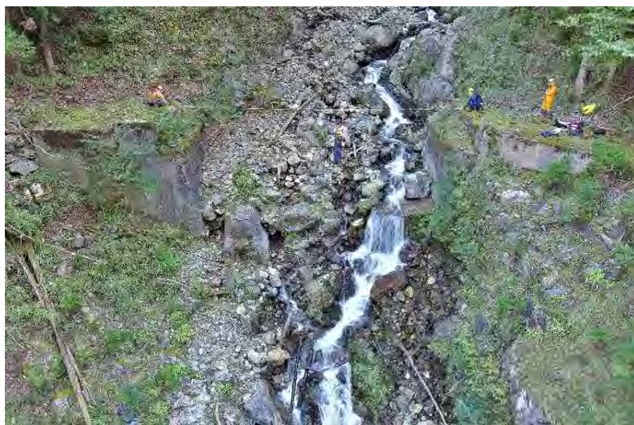
父ヶ谷大台線（父ヶ谷林道）改良工事予定箇所（大台町）
