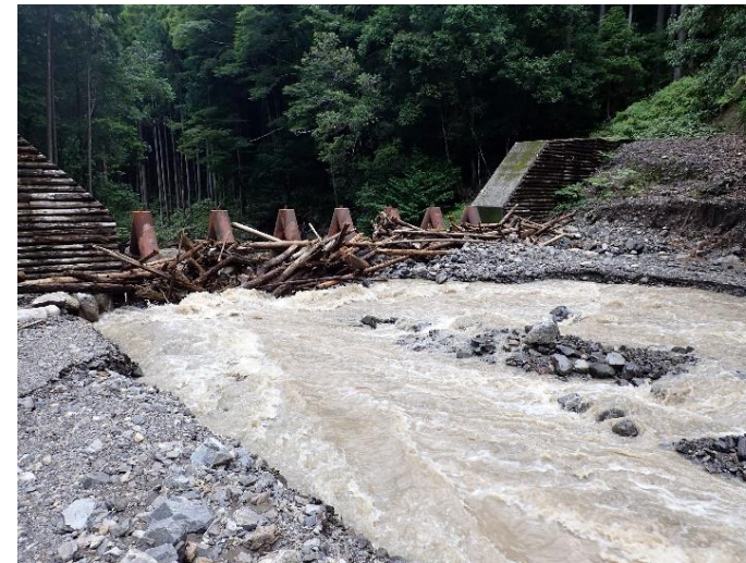
流木、土砂の捕捉状況(令和5年8月)
