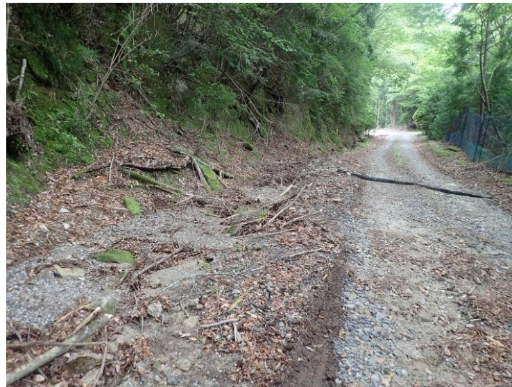
林道改良工事予定箇所 (大又国有林 熊野市)
