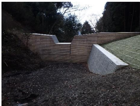
木材残存型枠の設置 (京都市 安祥寺山国有林)
