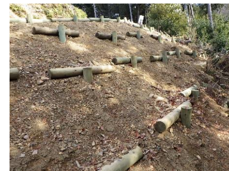
【木製杭工設置の状況】 (京都市 安祥寺山国有林)
