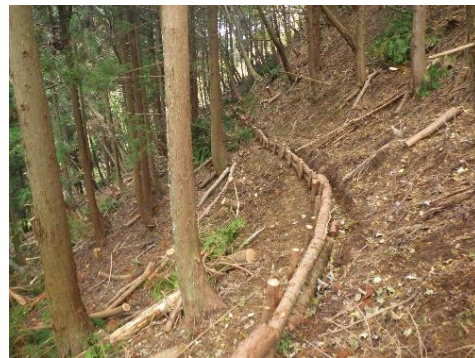
本数調整伐箇所の丸太筋工設置 (京丹後市 須川国有林)
