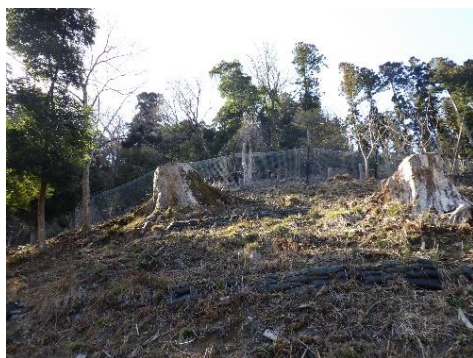
【斜面上部における地山補強土工 左：R7実施、右：R8予定】 (京都市 貴船山国有林)
