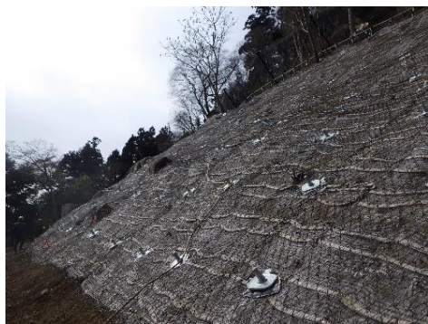
【斜面上部における地山補強土工 左：R7実施、右：R8予定】 (京都市 貴船山国有林)
