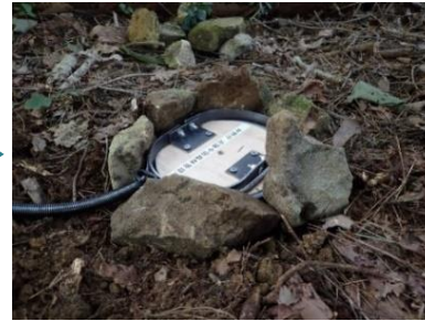
③塩ビ管の上に踏み板をセット
