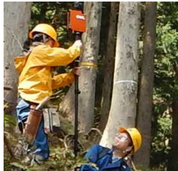
地上レーザ測量
