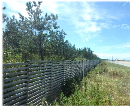
強風等から植栽木を保護するための防風柵の設置
