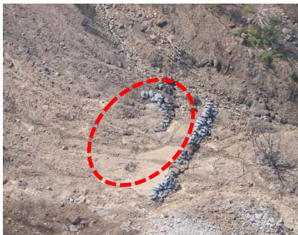
【施工箇所（袋型石詰土留め工の上部）】
