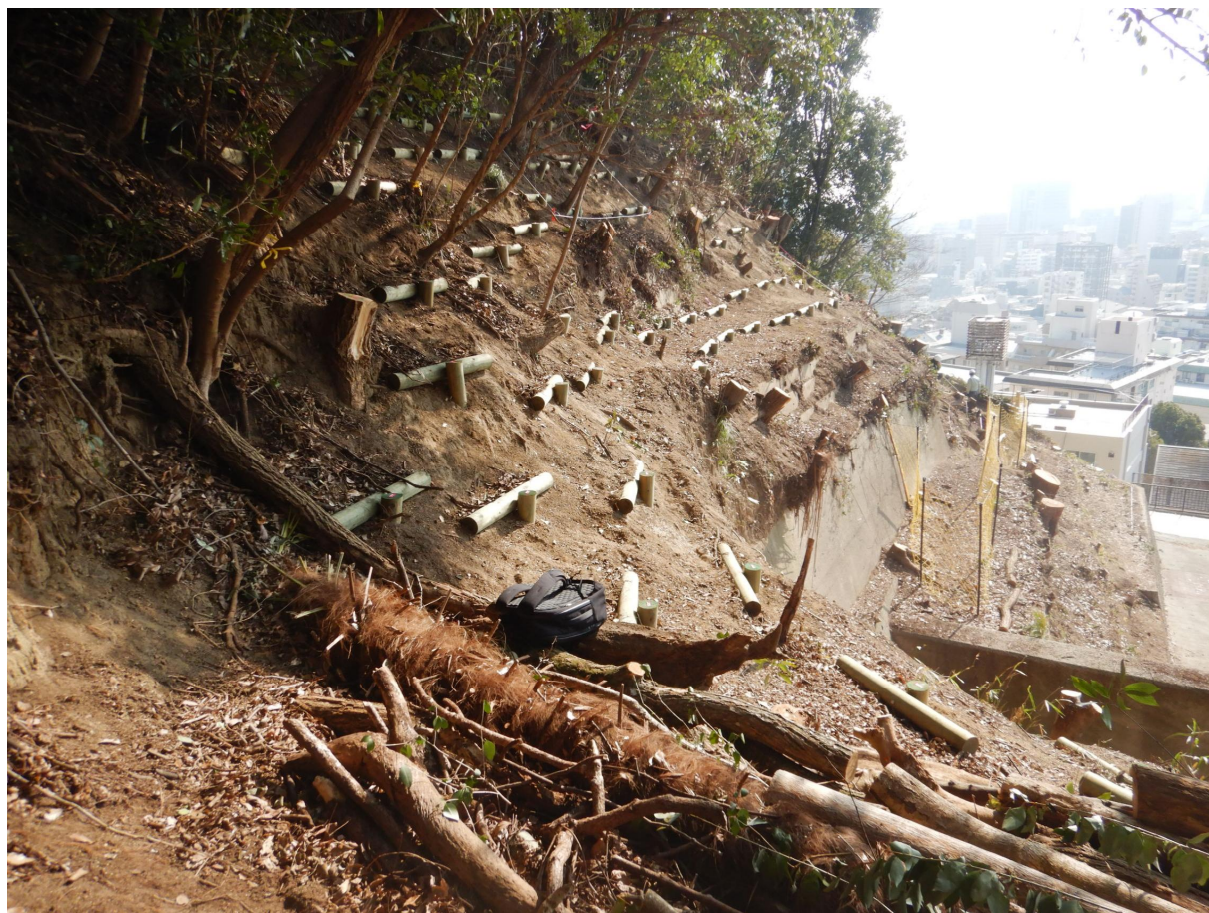
写真：木杭根系工法の完了後の状況（神戸市堂徳山国有林）
