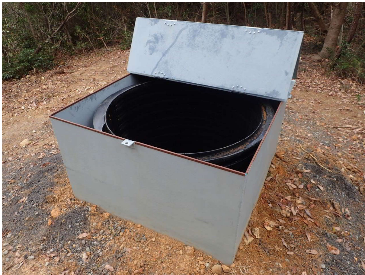
写真：大型排水管の設置状況（たつの市新宮滝谷国有林）
