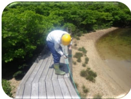
夜叉ヶ池木道の点検、修理 （南越前町 岩谷国有林）
