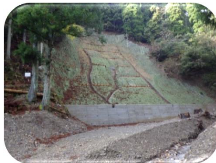
令和5年11月竣工 小河山腹工事 (敦賀市 小河国有林)
