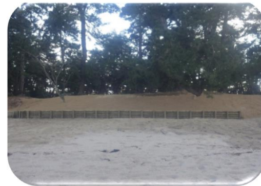
マツの土壌となる砂の流失を防ぐ養浜工 (敦賀市 松原国有林)
