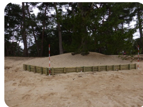
マツの土壌となる砂の流失を防ぐ養浜工 (敦賀市 松原国有林)
