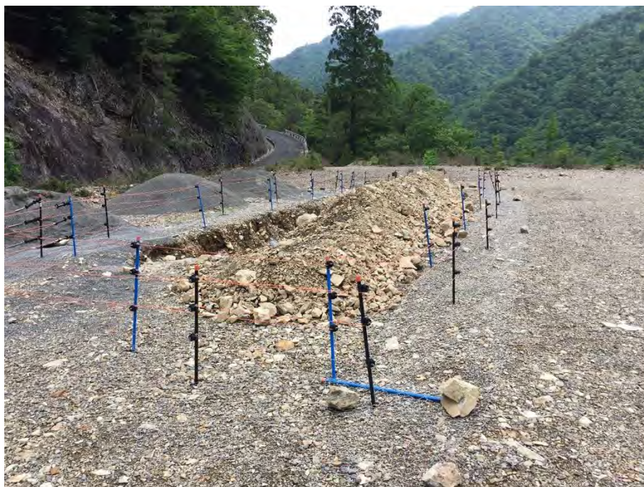
図 3-10 電気柵とアース用ワイヤーメッシュの設置
