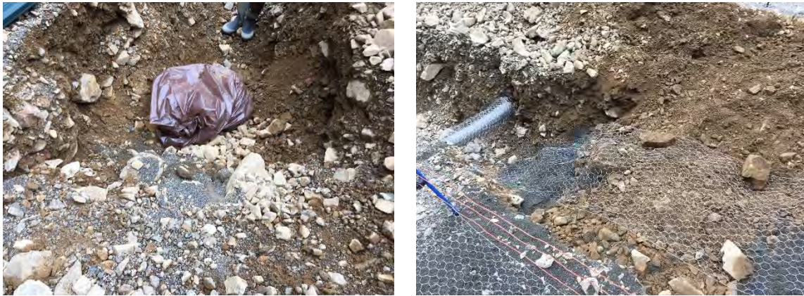
図 3-9 生分解性ガスバリアシート、ワイヤーメッシュを使用した埋設
