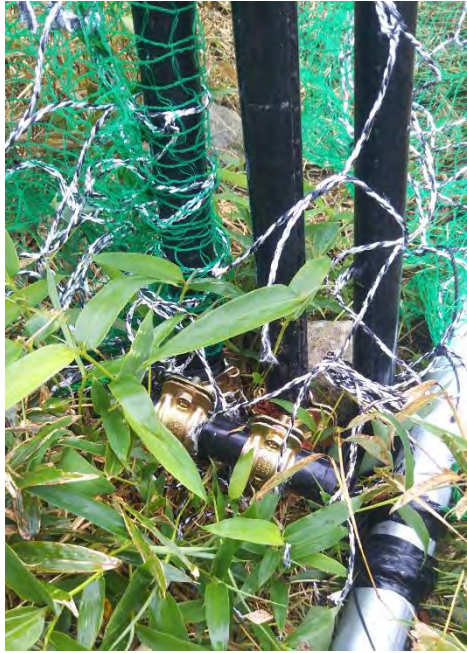
図 3-25 隙間を防ぐための支柱の設置
