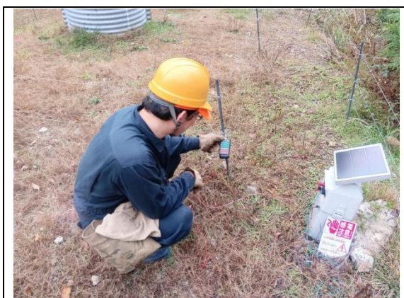
写真 1 5 電圧確認の様子
