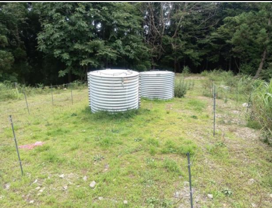
写真6 大型排水管(コルゲート管)
