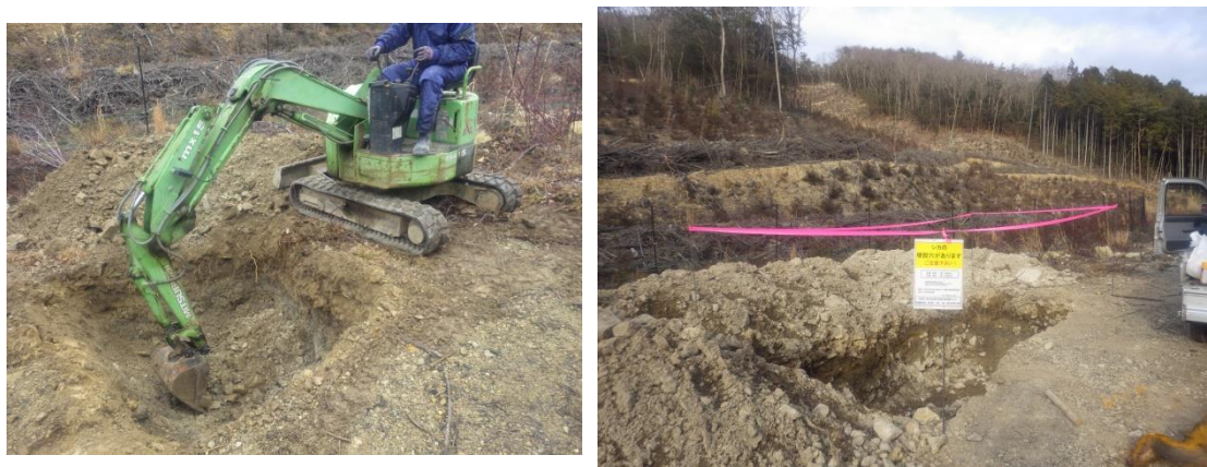
写真5、6. 大師谷の埋設穴掘削作業（左）と規制線・注意喚起看板（右）
