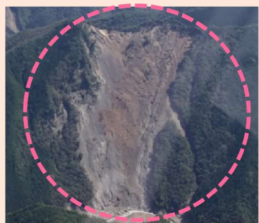
赤谷工区（被災直後） ・崩壊規模 24.86ha ・対策：山腹工及び土留工
