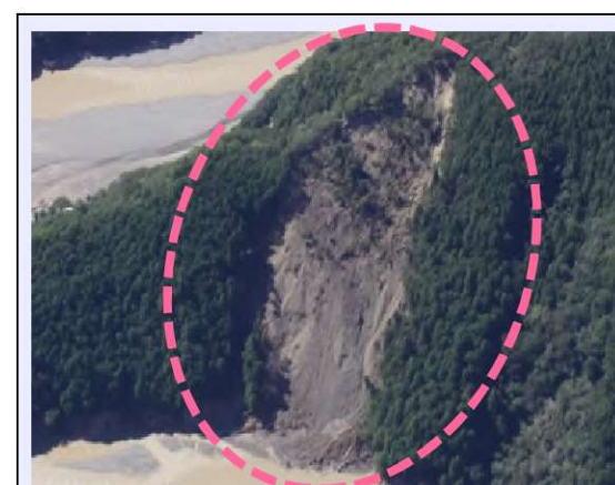
折立工区（被災直後） ・崩壊規模 2.36ha ・対策：山腹工 (平成27年度工事完了・移管済)
