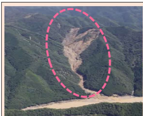
野尻工区 (被災直後) ・崩壊規模 20.44ha ・対策：谷止工、山腹工
