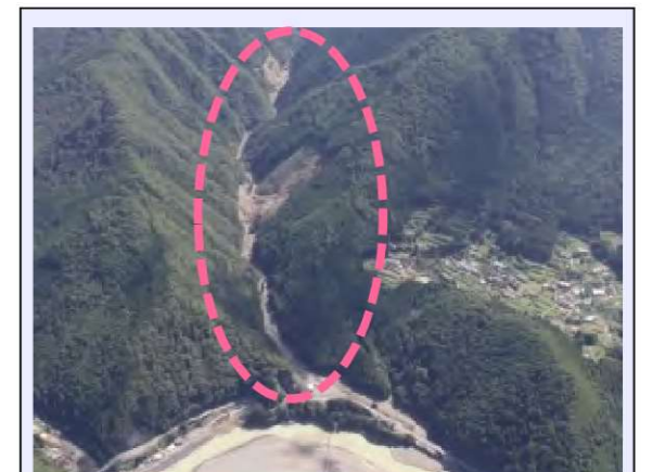
高津工区 (被災直後) ・崩壊規模 2.67ha ・対策：谷止工、山腹工 (平成30年度工事完了・移管済)
