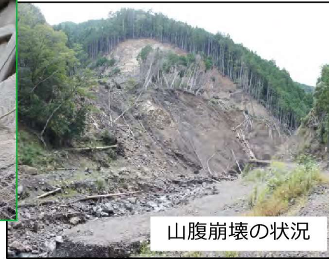
施工箇所付近（R7.10月）
