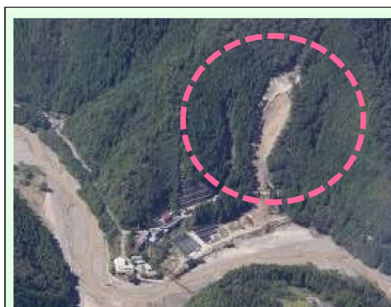
五百瀬工区(1号地)（被災直後） ・崩壊規模 0.47ha ・対策：山腹工 (令和4年度工事完了)
