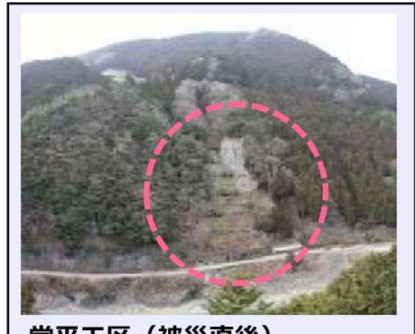
堂平工区（被災直後） ・地すべり兆候の規 3.00ha ・対策：アンカー工 （令和3年度工事完了・移管済）
