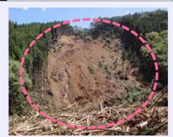
檜股工区（被災直後） ・崩壊規模 1.56ha ・対策：谷止工及び山腹工 （令和3年度工事完了・移管済）
