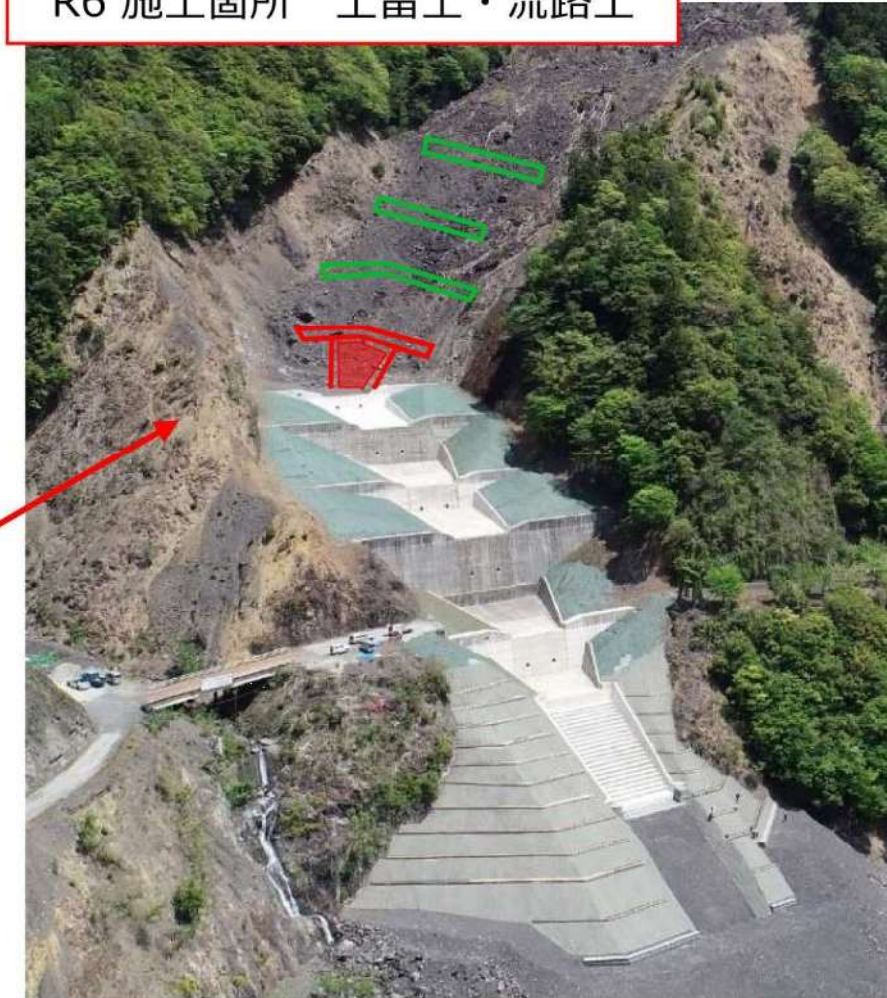
R6 施工箇所付近 (R7.5月)
