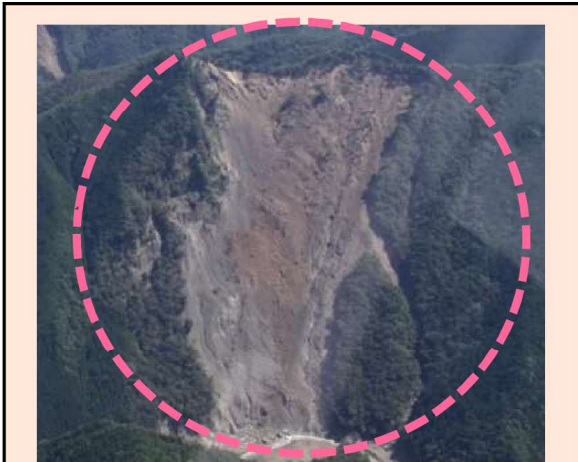
赤谷工区（被災直後） ・崩壊規模 24.86ha ・対策：山腹工及び土留工
