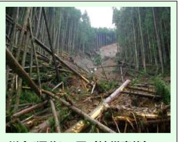
川合(深谷)工区（被災直後） ・崩壊規模 0.54ha ・対策：山腹工 (平成25年度工事完了)
