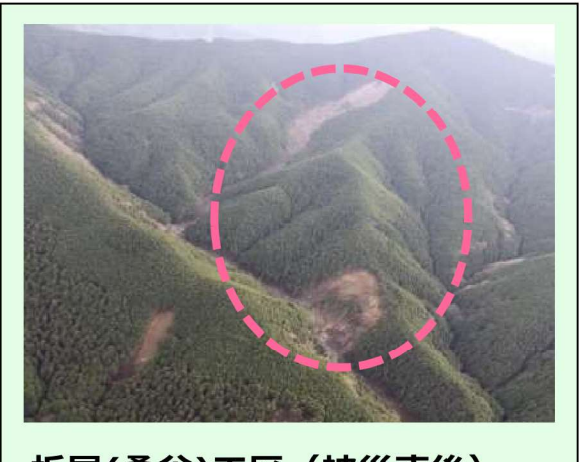
栃尾(桑谷)工区（被災直後） ・崩壊規模 1.5ha ・対策：谷止工及び山腹工 (令和3年度工事完了)
