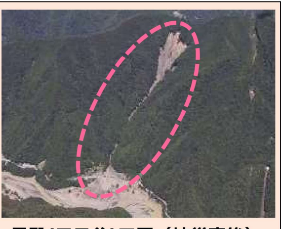
長殿(テラ谷)工区（被災直後） ・崩壊規模 2.75ha ・対策：谷止工、山腹工
