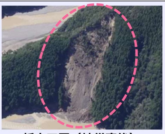
折立工区（被災直後） ・崩壊規模 2.36ha ・対策：山腹工 (平成27年度工事完了・移管済)
