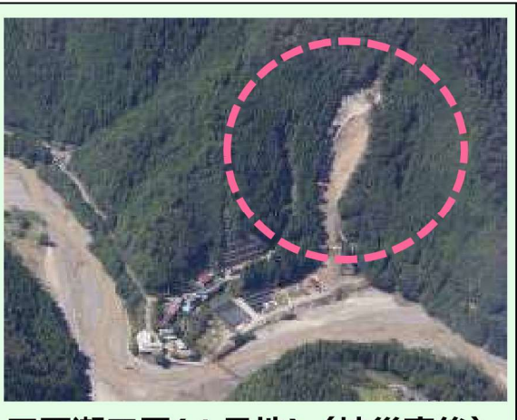
五百瀬工区(1号地)（被災直後） ・崩壊規模 0.47ha ・対策：山腹工 (令和4年度工事完了)
