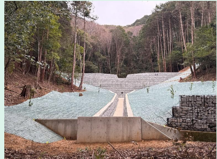
施工後（溪間工・水路工）
