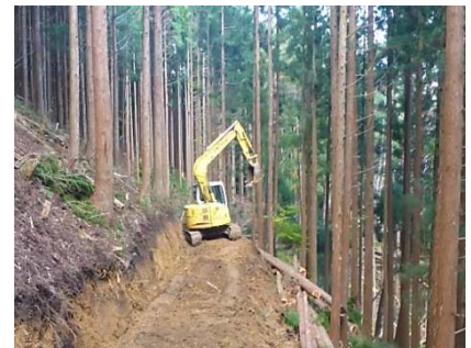
(森林作業道の作設状況 桧股国有林:野迫川村)
