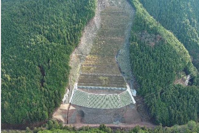
山腹工施工状況：坪内工区 坪内（天川村）R7.12
