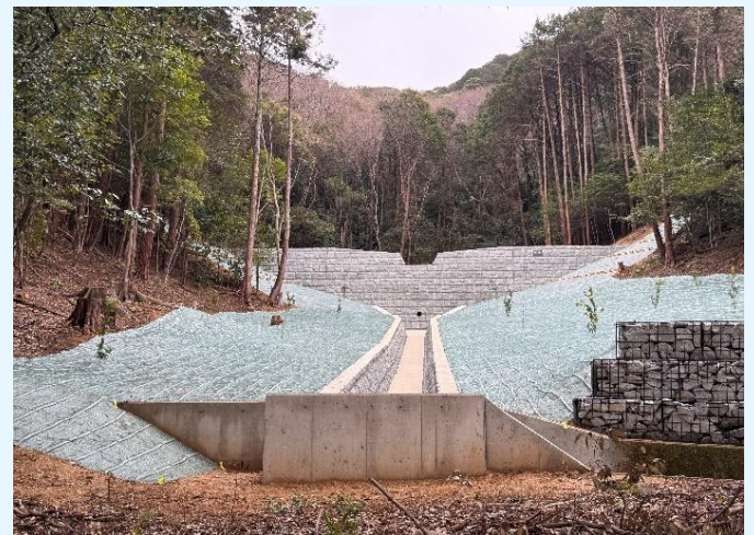
▲【治山工事完了状況 畝傍山国有林（橿原市）】
