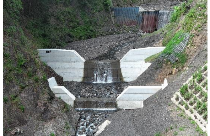
溪間工施工状況：今西工区 今西（十津川村）R7.9
