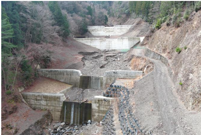
R7.3谷止工施工状況：山崎谷工区 山崎谷3（十津川村）
