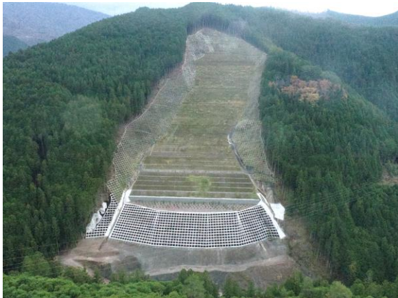
R6.12山腹工施工状況：坪内工区 坪内（天川村）
