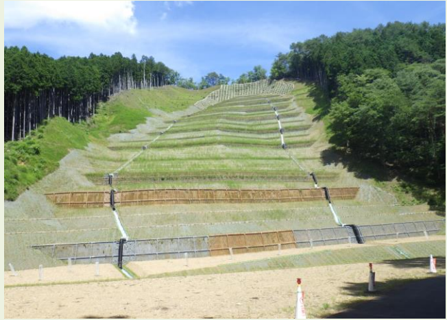
▲【治山工事完了状況 桧股工区（野迫川村）】
