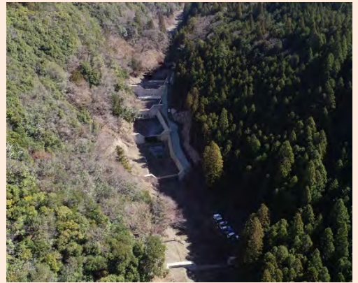
▲【R5.3完成 河津谷工区（十津川村）】
