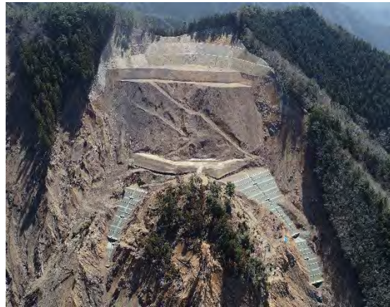
R5.3山腹工施工状況：野尻工区 野尻（十津川村）
