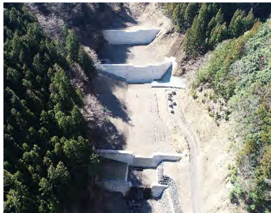
R5.2谷止工施工状況：山崎谷工区 山崎谷3（十津川村）
