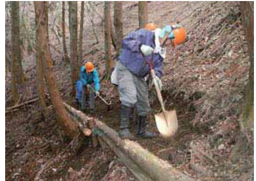
急斜面で苦労しながらの作業
