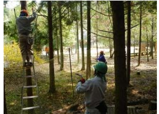
シカの飛び越え防止のネット張り
