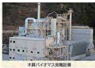
木質バイオマス発電施設 木質バイオマス発電施設.jpg
