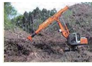
スーパーロングリーチグラップル(地拵え) をタワーとして使用し、主索を用いない による集材機
