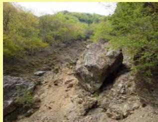
土砂崩壊が止まらない斜面
