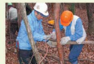
歩道の手すりの設置
