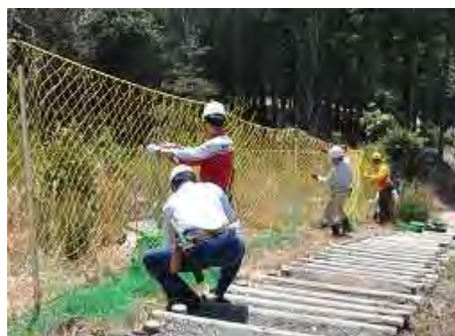
パッチディフェンスの設置
