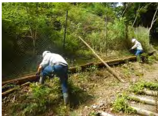
間伐材を利用した地際の補強
