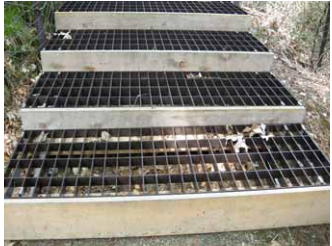
グレーチング式階段工(大台ヶ原の設置状況)
