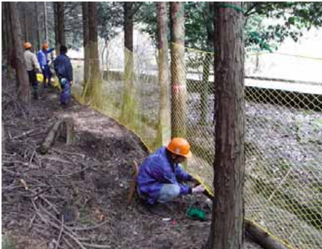
防鹿柵の設置状況
