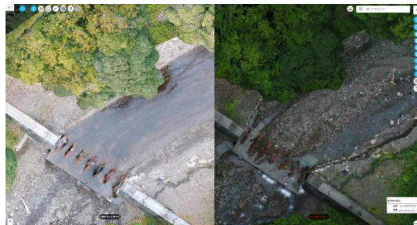
【土砂・流木撤去 完了時】
