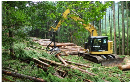
【生産事業箇所での集材の状況】 （西谷国有林 熊野市）
