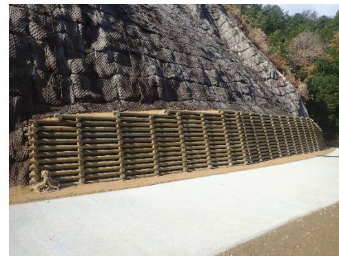
【木材を利用した土留工】 （御弁当谷（ごべつとだに）林業専用道改良工事）
