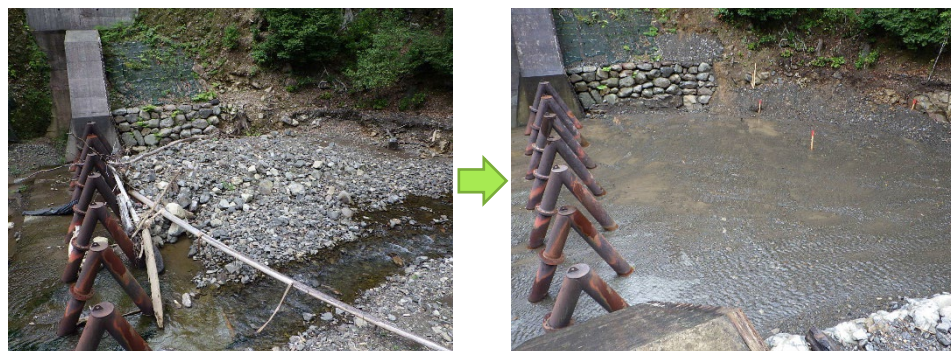
【流木等捕捉のためのスリット谷止工 土砂・流木撤去前後】
