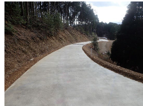
【森林共同施業団地内で利用者が多い御弁当谷林業専用道(4年度施工箇所)】(いなべ市 悟入谷国有林)
