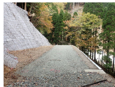
【4年度改良工事箇所】(松阪市 千石平国有林)
