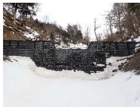
【令和4年度に施工した鋼製谷止工】
