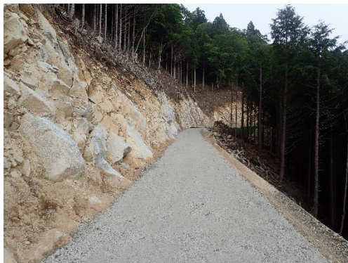
【4年度に開設した樫木平(保色山)林業専用道】
