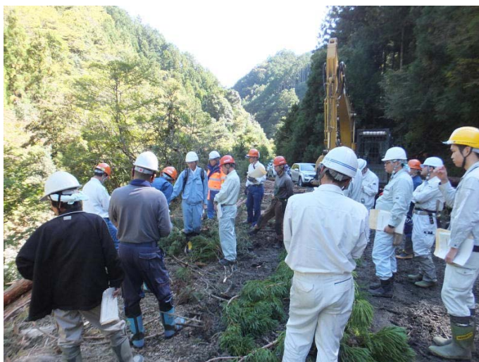
集材木で伐倒の際に クサビ使用したか手順を確認
