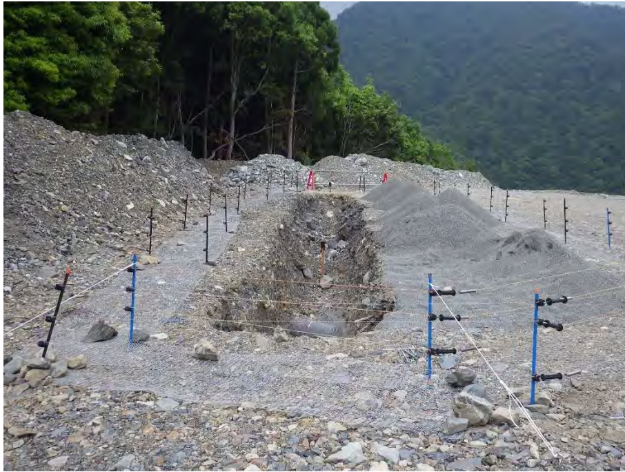
図 3-9 電気柵とアース用ワイヤーメッシュの設置
