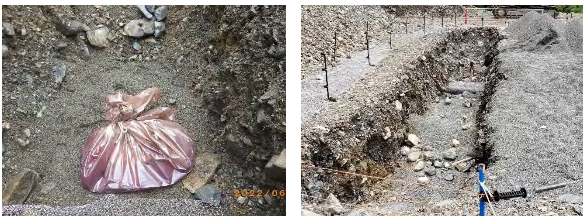
図3-8 生分解性ガスバリアシート（左）とワイヤーメッシュを使用した埋設（右）
