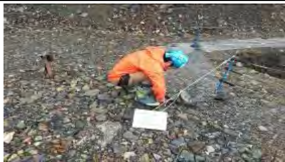
電気柵の設置
