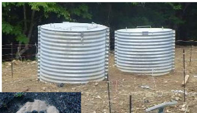
大型排水管の埋設状況 （大杉谷国有林）
