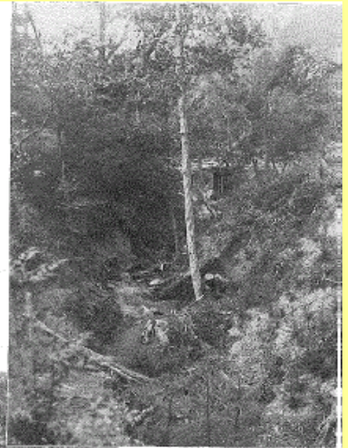
森雨 被害状況
