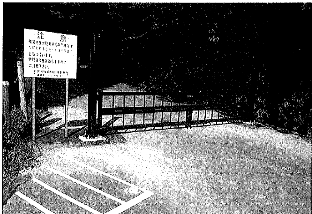
ゲート設置の様子
